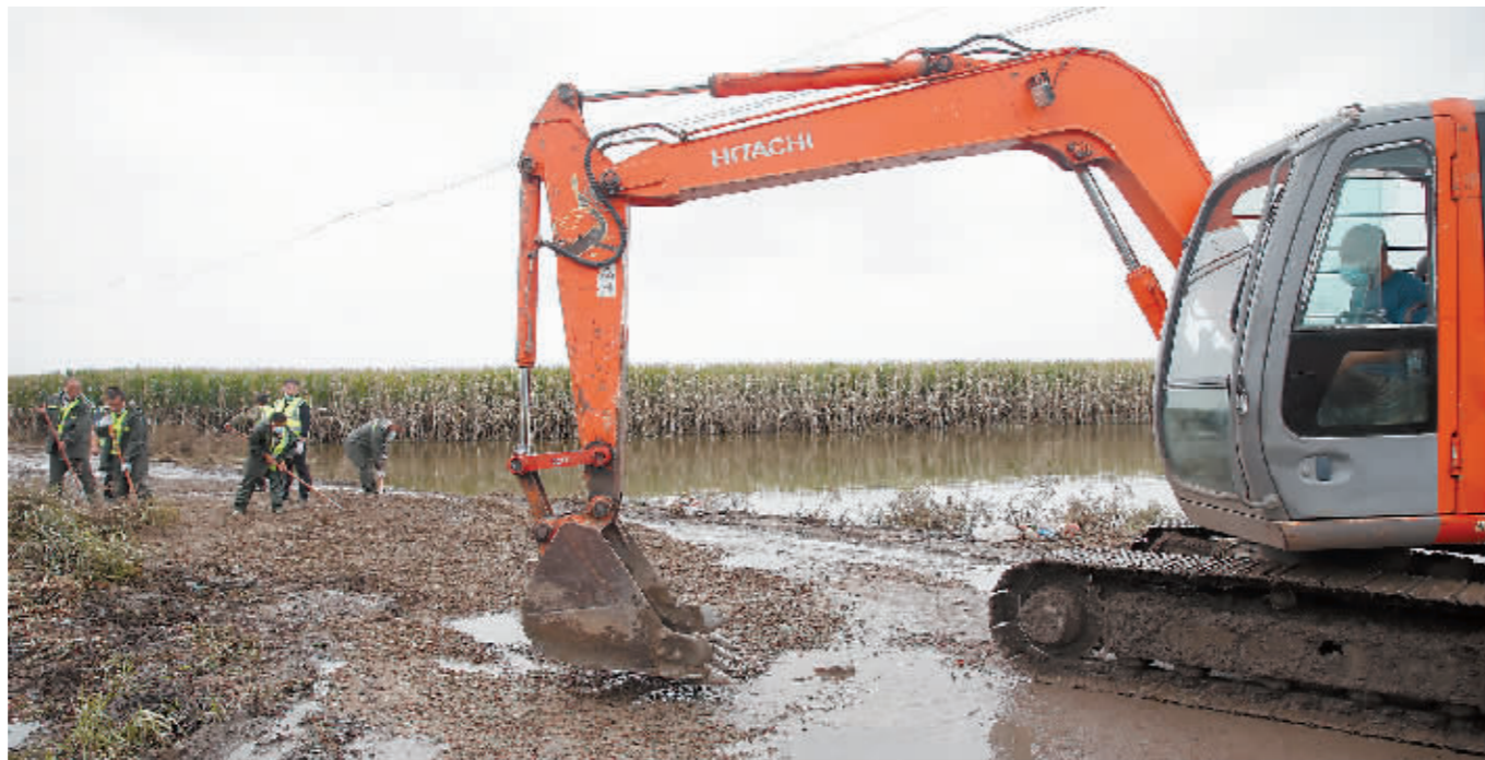
哈城发投集团组织大型设备抢修道路。
