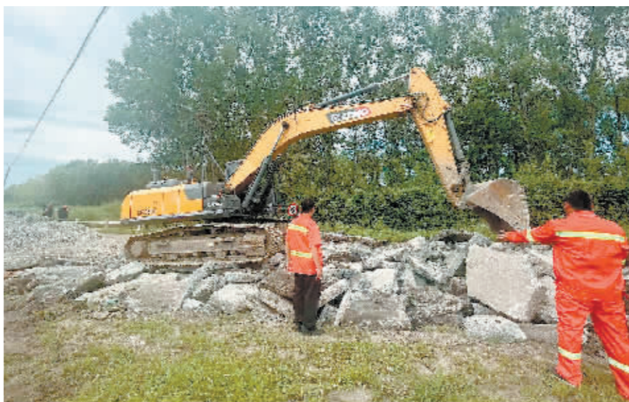
双城区抢修受损路段。
