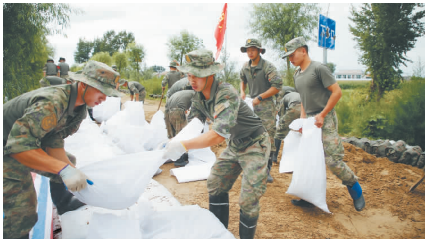
垒沙袋筑堤坝。
