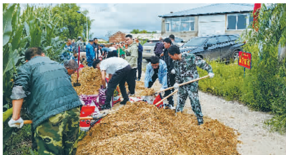
填装沙袋加固堤坝。
