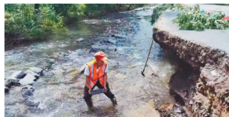
于永江回填被水淘空的路基。
