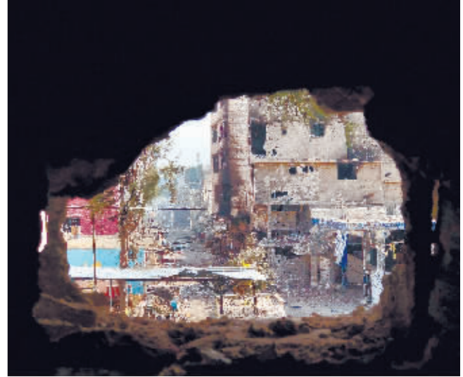
难民营受损建筑。
