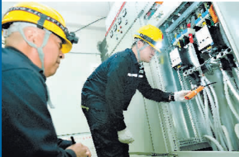
电力工作人员抢修电力设施。
