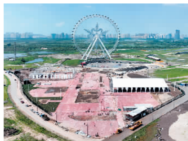
啤酒节场地搭建现场。
