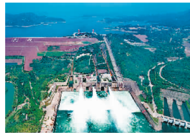
6月20日拍摄的黄河小浪底水利枢纽(无人机照片)。
