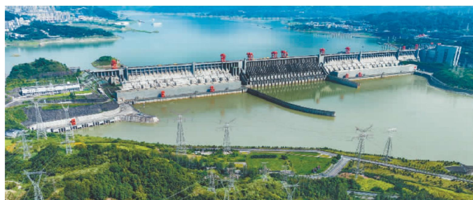
2023年7月10日,三峡电站首台机组投产发电整20年。20年来,三峡电站已累计发出16000多亿千瓦时清洁能源。三峡电站共安装34台水轮发电机组,总装机容量2250万千瓦,年设计发电量882亿千瓦时,是我国“西电东送”和“南北互供”的骨干电源点,电能昼夜不息被送往华东、华中、广东等地。
