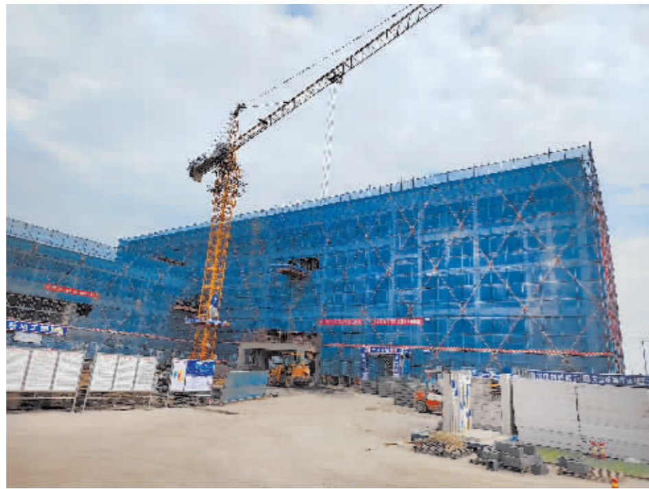
阿城科技产业园实验楼、科技楼楼体主体完工。
