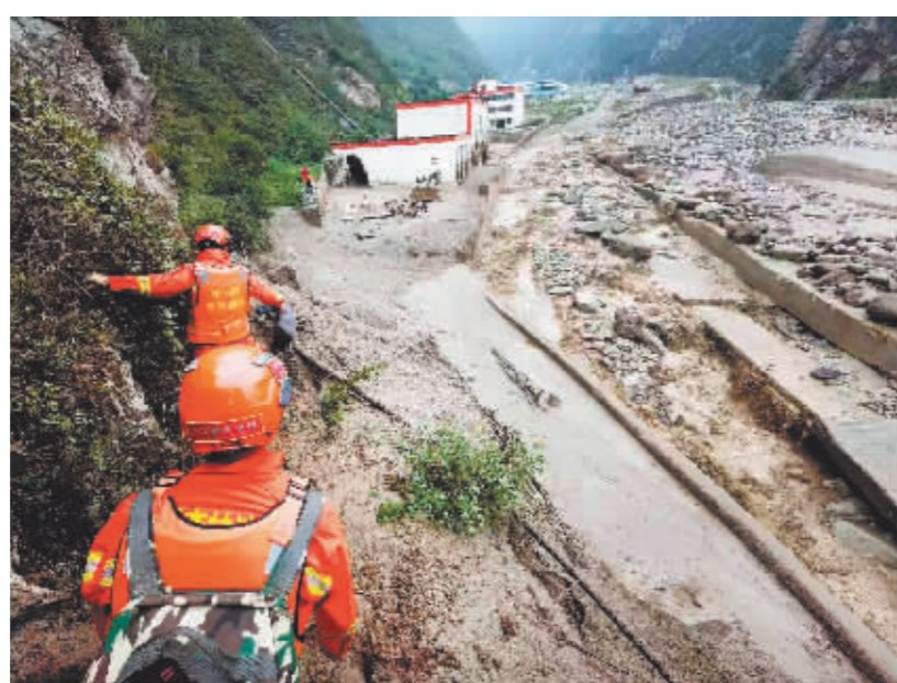
6月27日,救援人员在四川省汶川县绵虬镇板子沟泥石流灾害现场勘查。新华社发
