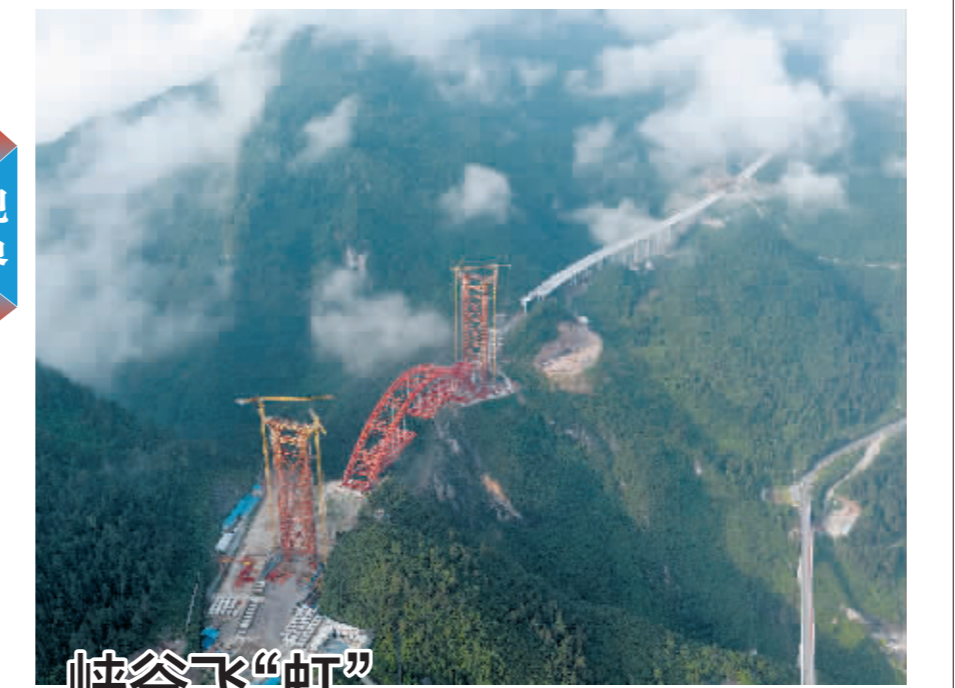
溇水河特大桥位于湖北省鹤峰县境内,大桥全长328米,横跨深度300多米的峡谷。目前,桥梁建设者正在进行钢架吊装施工作业,预计6月底完成吊装施工。 新华社发
