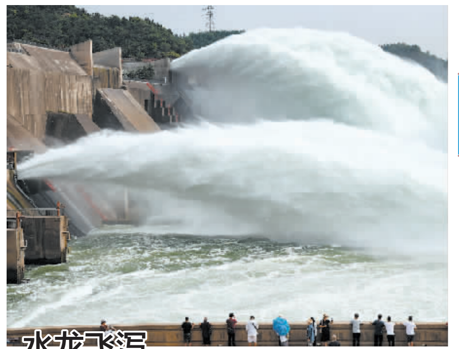
6月25日,黄河小浪底水库按4230立方米每秒流量泄洪,巨大的水流从高落差的出水口喷涌而出,景象壮观。 新华社发
