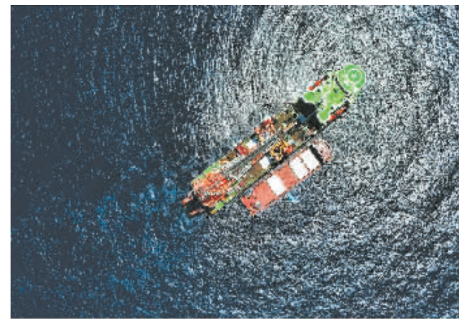
6月22日,“海洋石油201”在进行海管铺设作业。
