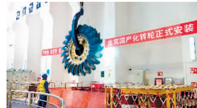
大型冲击式转轮安装。
