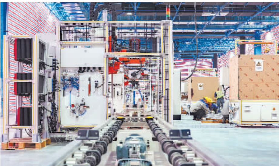
工作人员正在调试设备。
