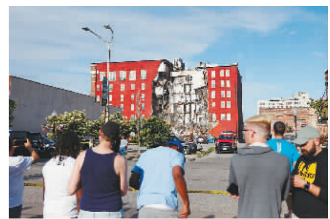
图为坍塌现场。
