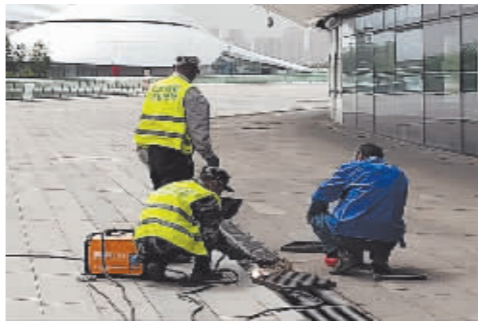
城管人员维修路面。
