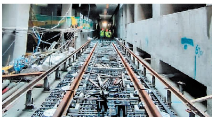
河松街地铁站施工现场进行铺轨施工。
