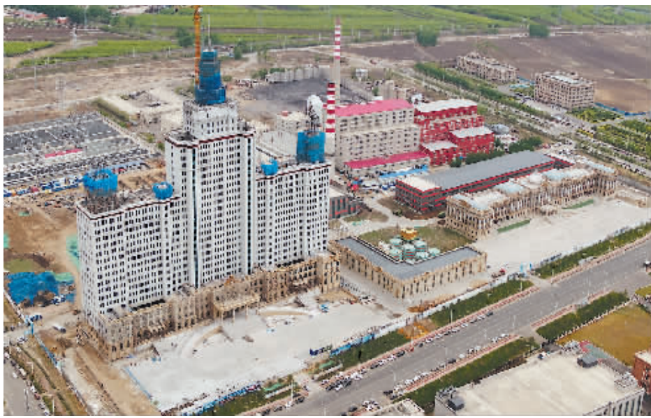
哈尔滨新区燃气热电联产项目工程现场。
