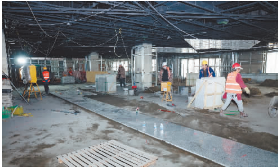
T1航站楼改造项目施工现场。
