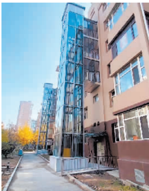
住宅加装电梯。
