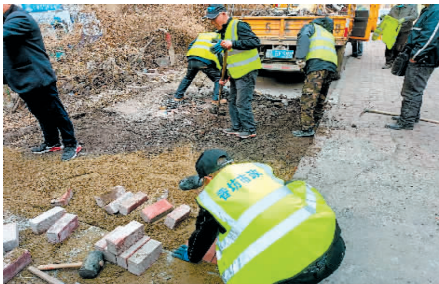
工作人员维修破损道路。
