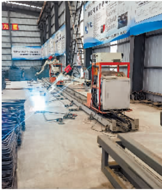
作业中的智能焊接机器人。
