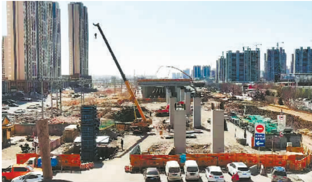
项目施工现场。
