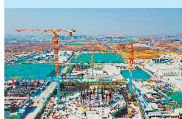
位于雄安新区启动区的中国中化雄安总部001大厦项目建设现场。
