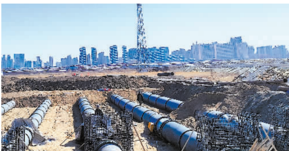
松花江水源上移项目管线敷设施工现场。
