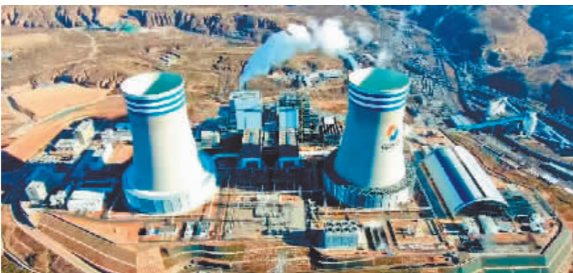
哈电锅炉自主研发的榆能杨伙盘项目2x660MW超超临界煤电一体化项目1号机组锅炉。
