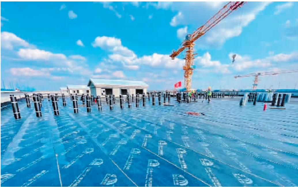
屋顶防水施工现场。(由受访者提供)
