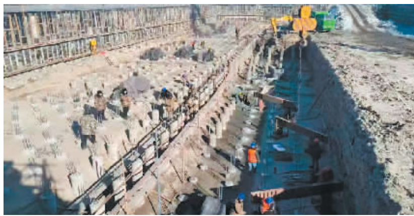
项目施工现场一派繁忙景象。
