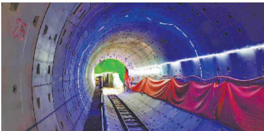
上海街站至公路大桥站隧道顺利贯通。
