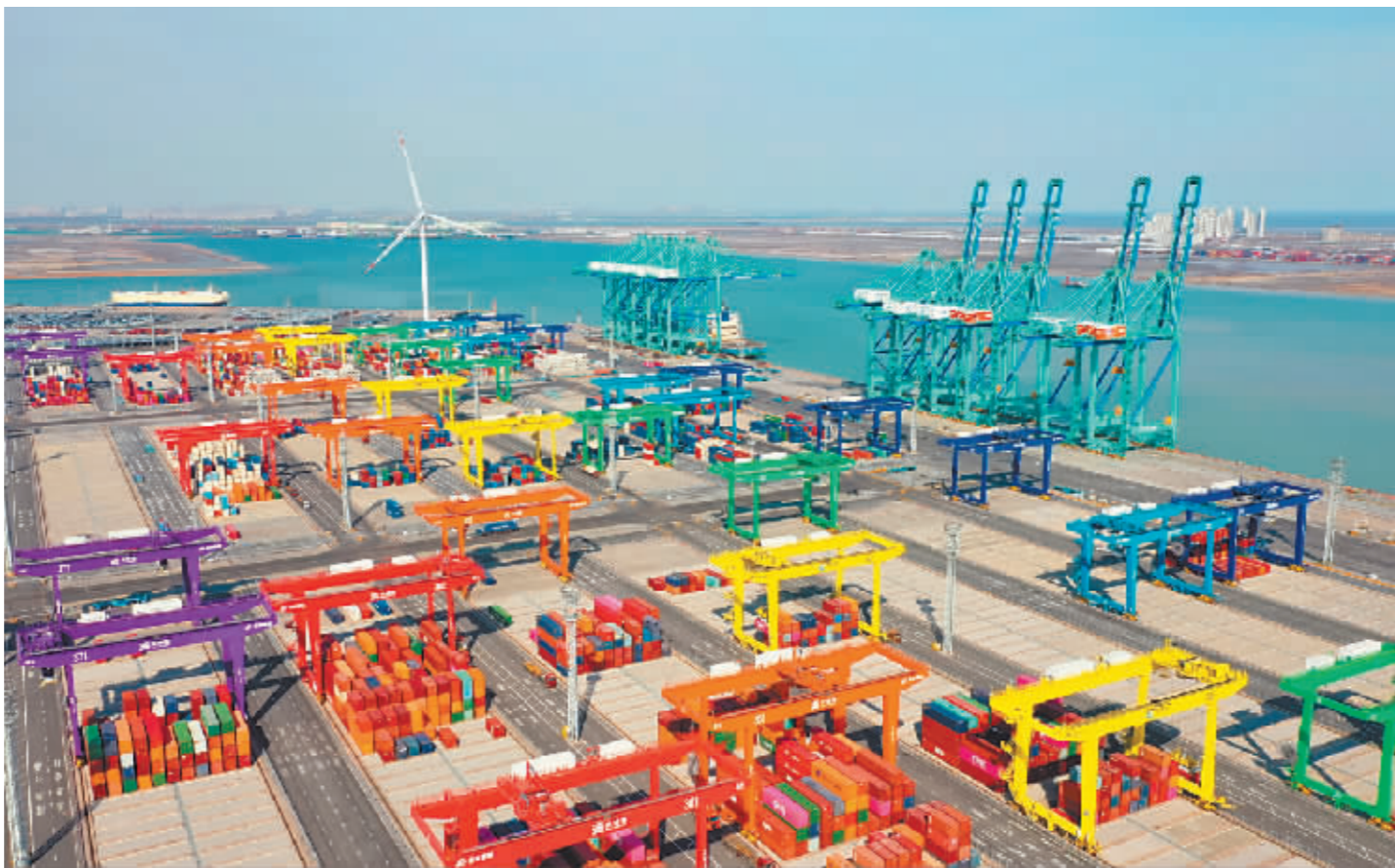
这是2月21日拍摄的天津港全物联网集装箱码头（无人机照片）。
