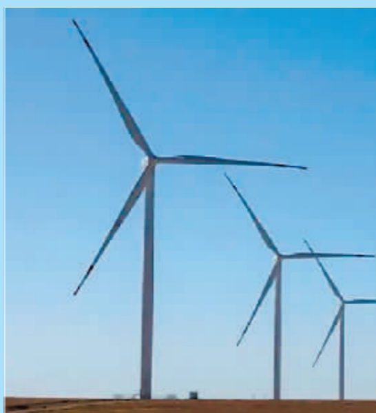
这是哈萨克斯坦扎纳塔斯风电场风机。扎纳塔斯100兆瓦风电项目是中哈合作的中亚最大风电项目。
