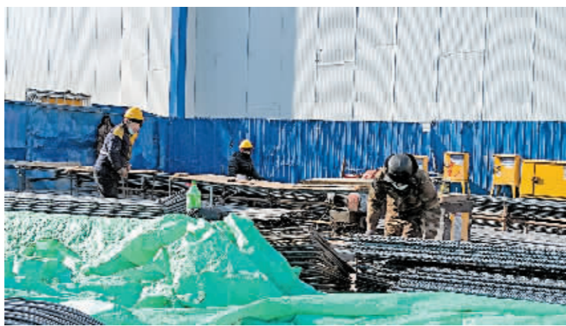
地铁施工现场恢复了往日的忙碌。
