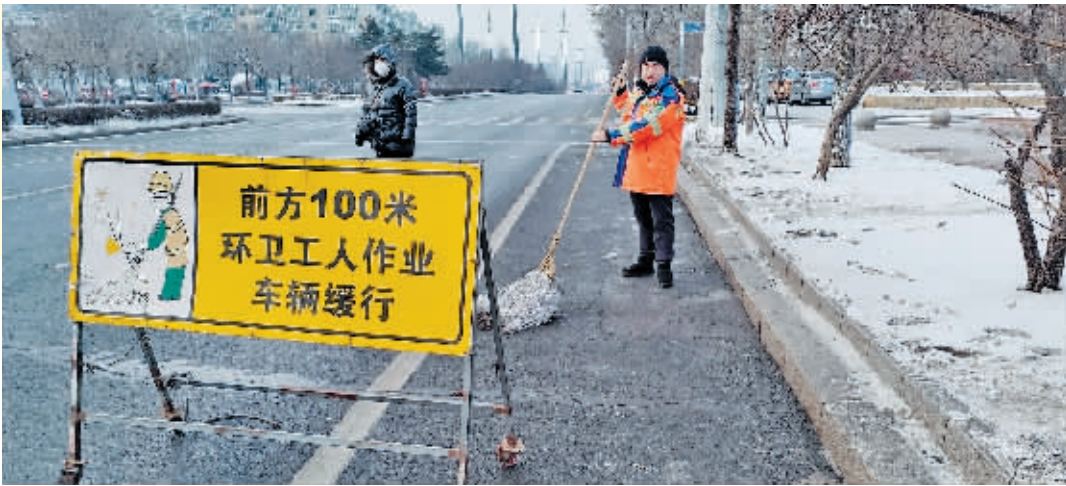
环卫工人在街面作业。
