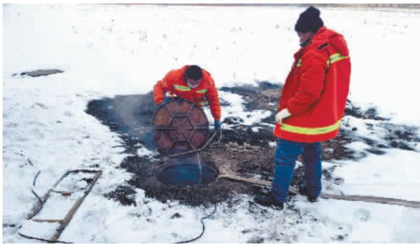
巡线员进行管网隐患排查。
