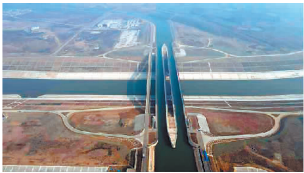
12月30日拍摄的试通水通航后的引江济淮总干渠渡槽。
