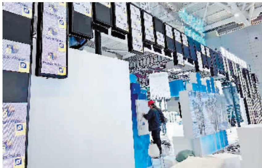
工作人员在展馆内施工。
