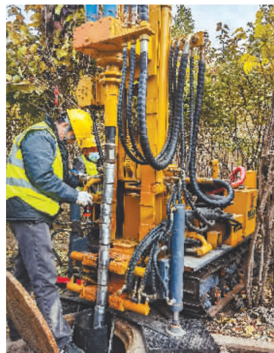
工作人员利用“非开挖修复技术”进行管道维修。
