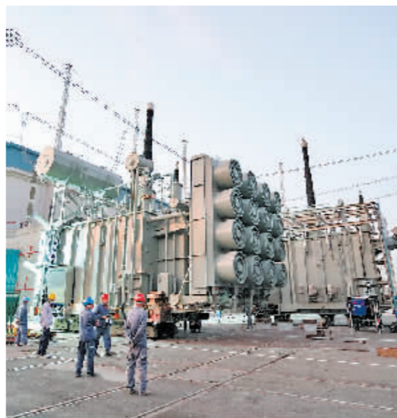
图为换流变压器有载分接开关安装现场。
