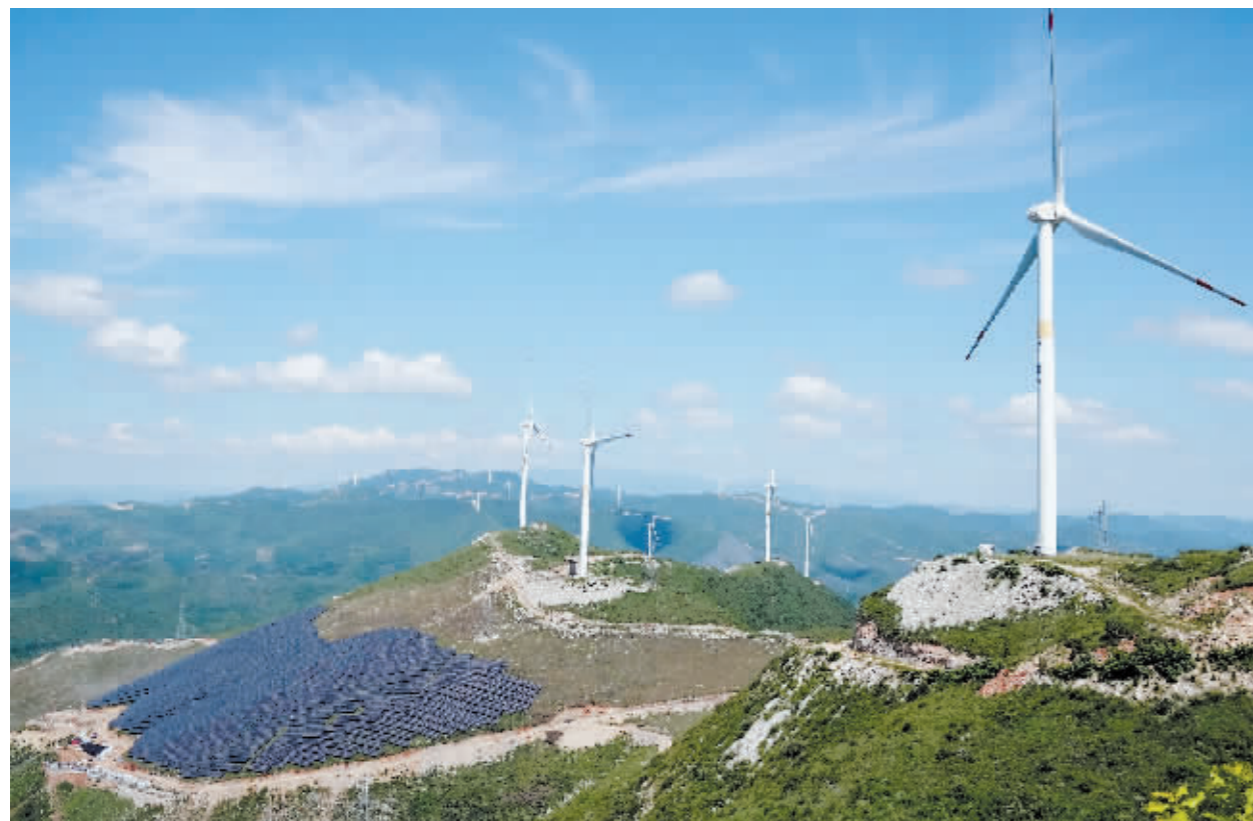
图为8月17日,在河北省秦皇岛市一处荒山上,工人在150兆瓦光伏电站建设工地施工。 新华社发
