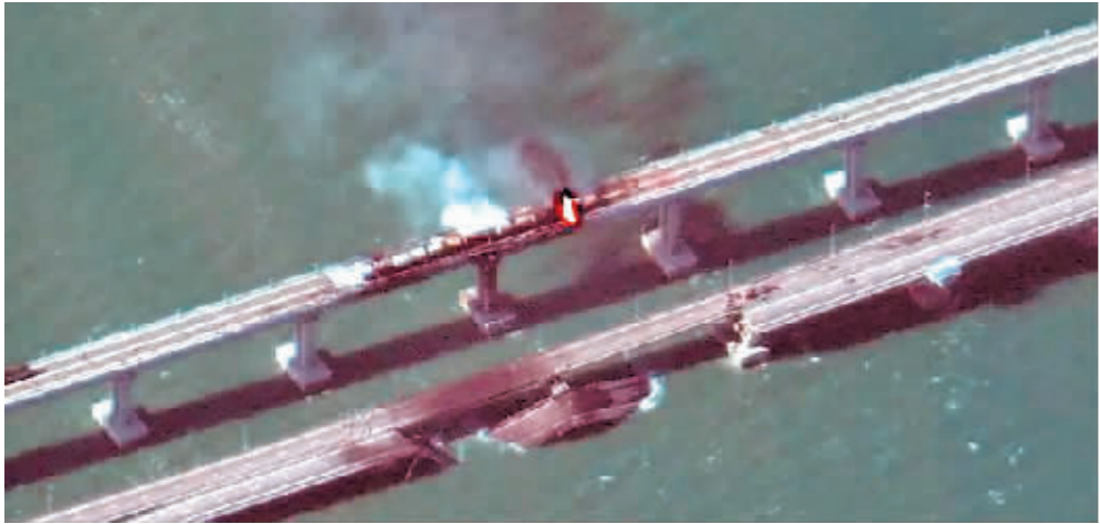
克里米亚大桥发生爆炸现场图。
