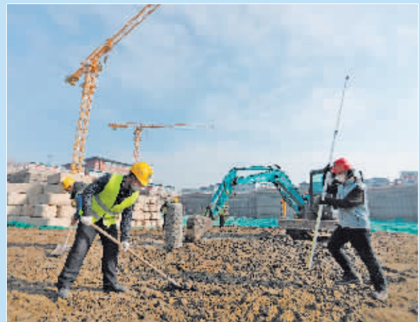
工人在北京市通州区丁各庄公租房项目工地施工。
