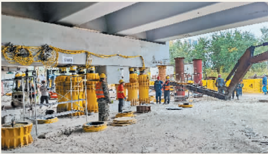
“十一”期间,东三环快速路建设者们坚守岗位。
