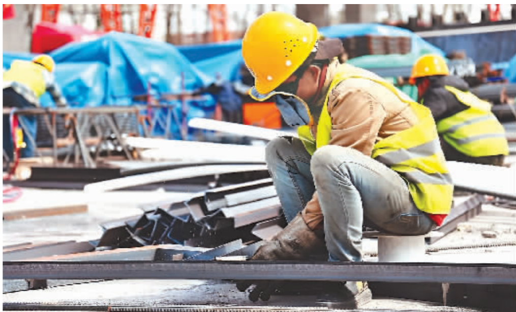
建设者们正在加紧施工。
