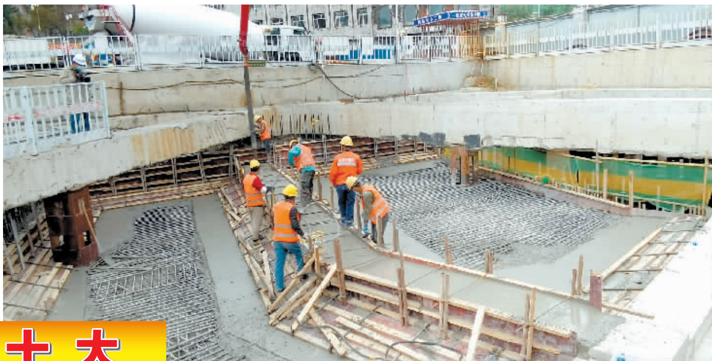
哈尔滨地铁3号线人民广场站施工现场。
