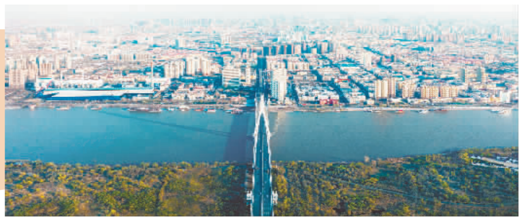
航拍松浦大桥。
