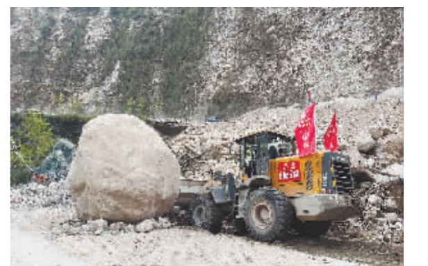
救援人员在抢修泸定县城与磨西镇之间的公路。
