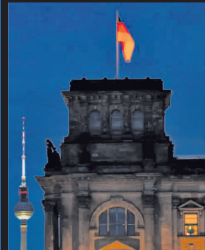
为节约能源,德国柏林标志性建筑立面照明减少。
