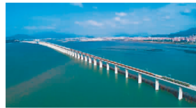
建设中的新建福州至厦门铁路跨海大桥。(资料图)
