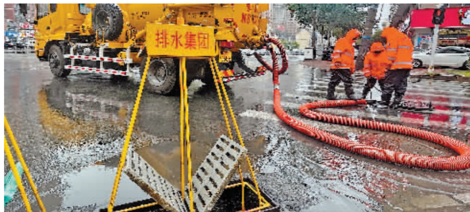
工作人员冒雨在路面排除积水。
