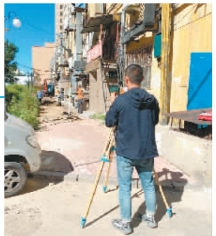
小区道路维修施工现场。
