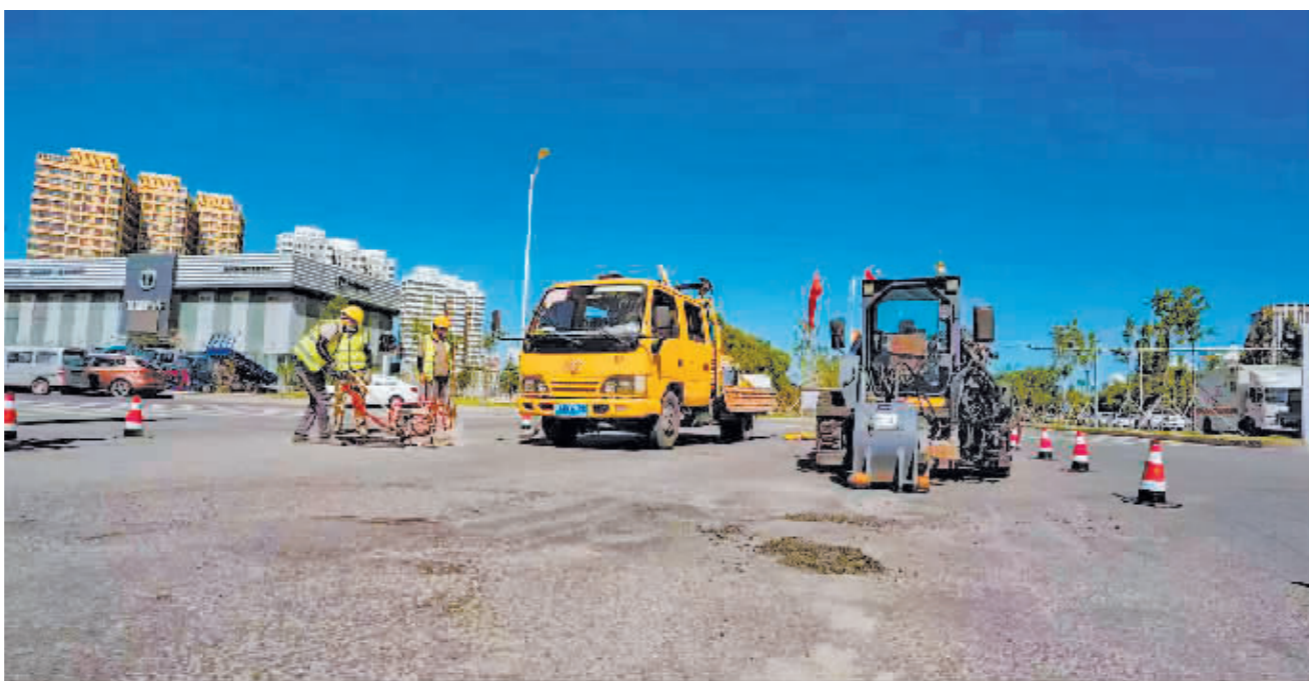
松北区中环路道路维修施工现场。
